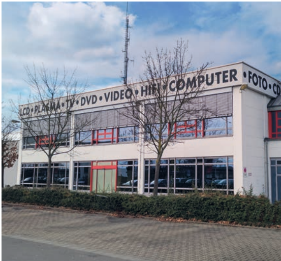
Provisorische Außenstelle in der Friedrich-Gauß-Straße in Schweinfurt (Ansicht am 12. Februar 2018).
